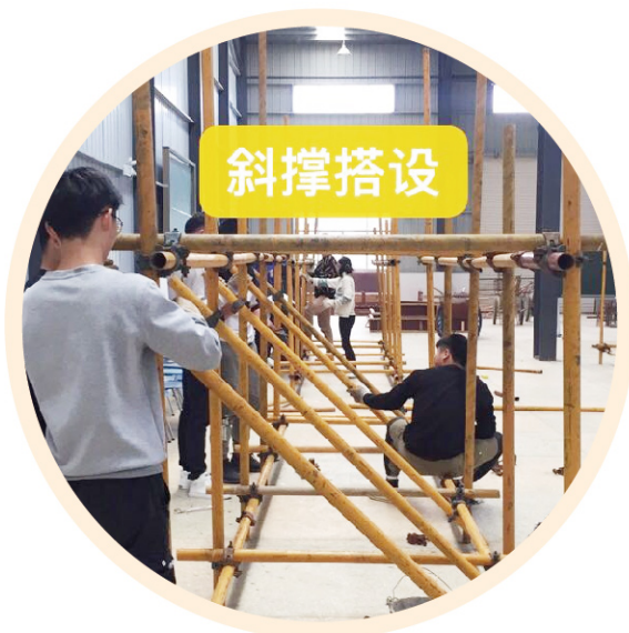
脚手架搭设实训
